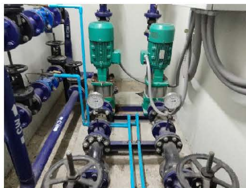
เครื่องสูบน้ำชั้นใต้ดิน
