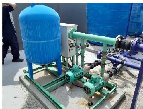
เครื่องสูบน้ำเสริมแรงดัน
