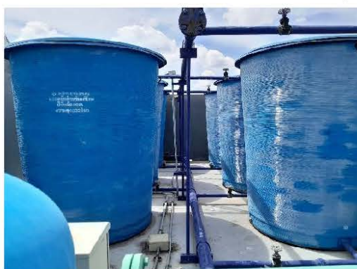
ถังเก็บน้ำชั้นหลังคา
